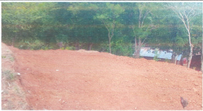
Foto1: Instalación de cimiento corrido de block
